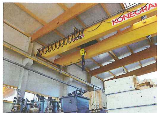
Ausgestattet mit einem 32-t-Kran können in der neu errichteten 10 m hohen Lagerhalle auch Schwerlasten eingelagert werden.
